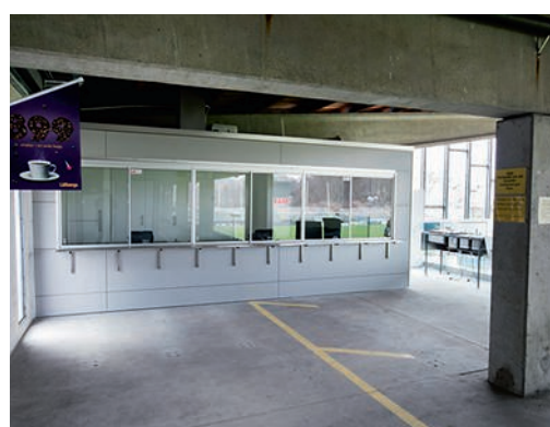
Kioskerna har fått fler försäljningsluckor än tidigare.
